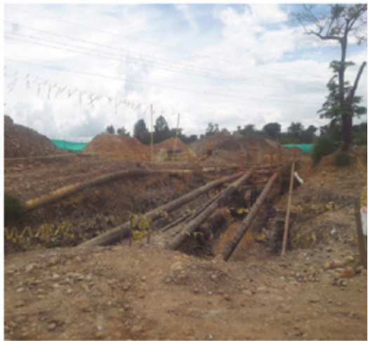
Enterramiento de líneas de flujo petrolero
